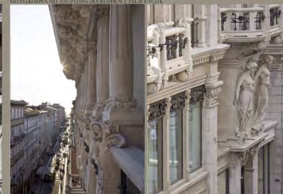
BLICK VON DER LOGGIA ÜBER DIE VIA SAN NICOLO
